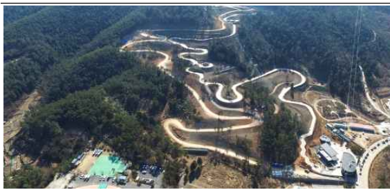
통영 루지체험장 전경 (경남도민신문, 2017.2.7)
